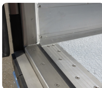
Caoutchouc de rupture du pont thermique et profil aluminium accès plancher
